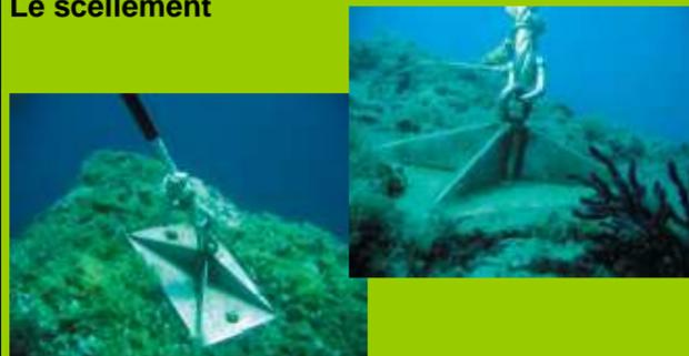
Tout dispositif suffisamment résistant composé d'une platine ou d'un simple organeau muni d'un ou plusieurs tirants scellés dans la roche grâce à une résine appropriée ou tout autre produit adapté.
